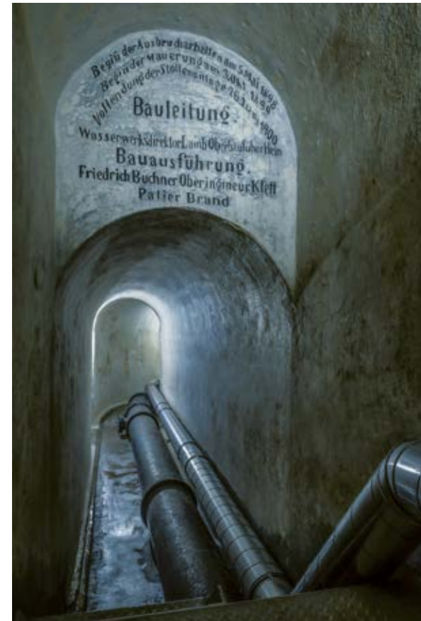
Der Schulhausstollen in Zell. Noch am Tag der notariellen Niederlegung des Wasservertrags am 5. Mai 1898 wurde mit den Ausbruchsarbeiten am Schulhausstollen begonnen. TWV-Fotoarchiv, Rolf Nachbar.
