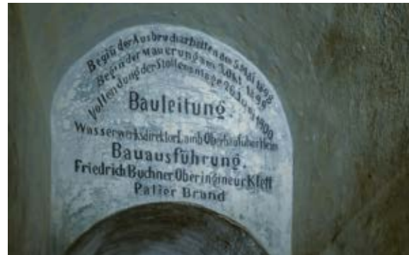
Der Schulhausstollen in Zell. Noch am Tag der notariellen Niederlegung des Wasservertrags am 5. Mai 1898 wurde mit den Ausbruchsarbeiten am Schulhausstollen begonnen. TWV-Fotoarchiv, Rolf Nachbar
