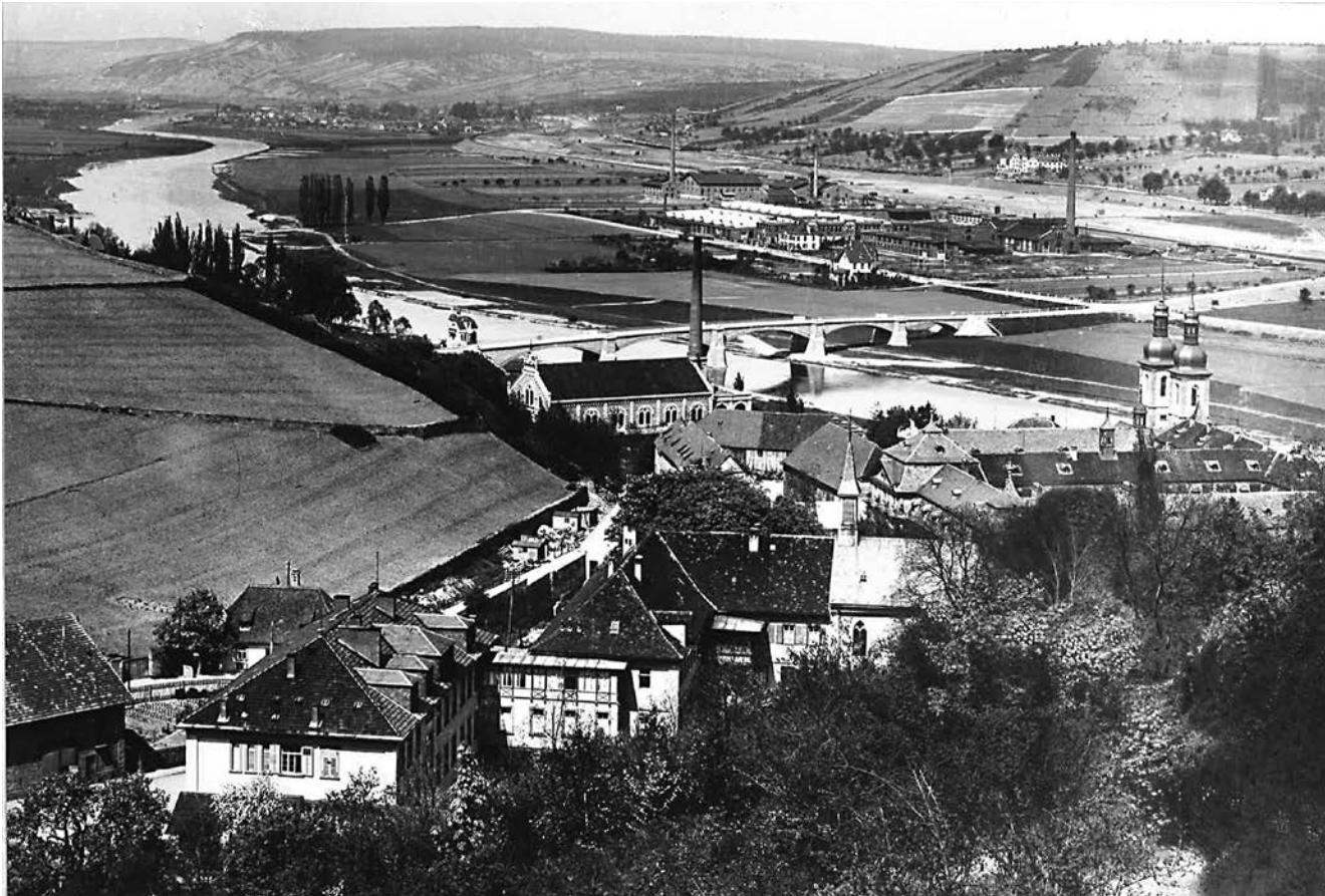
Blick über das Kloster Oberzell auf das Zeller Wasserwerk mit Schornstein, die Zeller Mainbrücke und das damalige Firmengelände von Koenig & Bauer, Foto 1923. Zeller Bilderchronik, Fotosammlung Emil Weigand, GA Zell, Karton 2, Bild 2.
