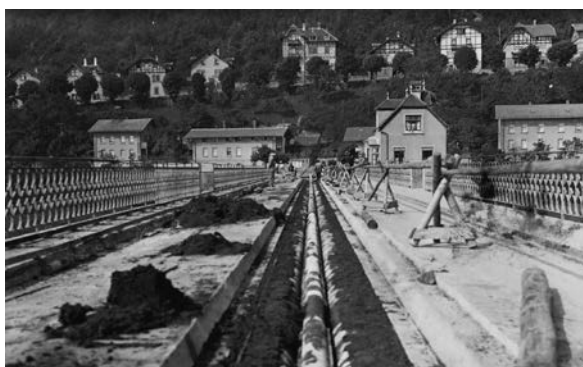
Bau der zweiten Wasserleitung Zell – Würzburg, März 1930, Historisches Archiv der WVV
