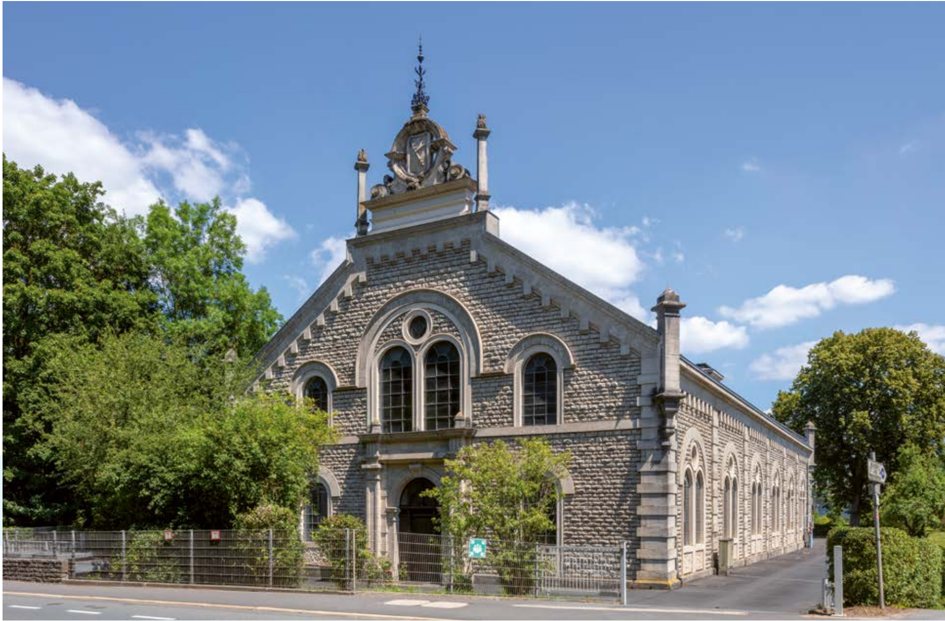
Außenansicht des Wasserwerks Zell, Juli 2020, TWV-Fotoarchiv, Gerhard Hagen
