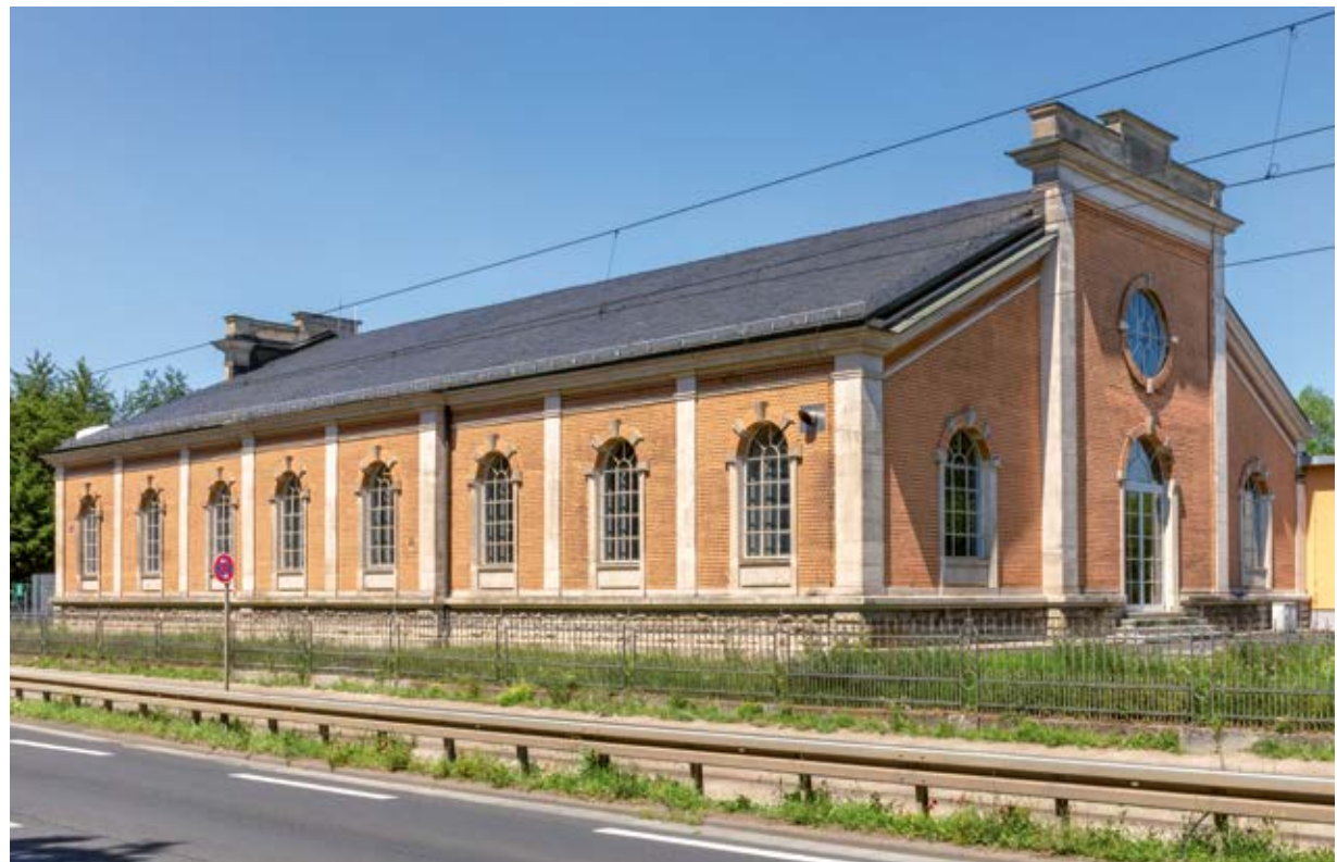
Außenansicht des Wasserwerks Mergentheimer Straße, Juli 2020, TWV-Fotoarchiv, Gerhard Hagen
