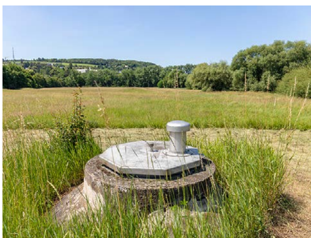
Fassungsgelände des Wasserwerkes Mergentheimer Straße
