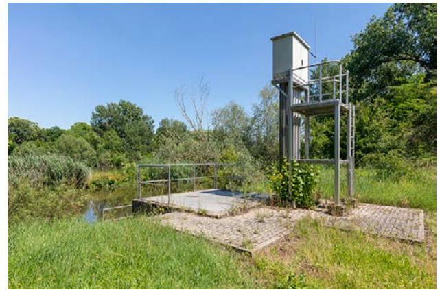
Mainwasserentnahmebauwerk des Wasserwerkes Mergentheimer Straße, Foto: Gerhard Hagen
