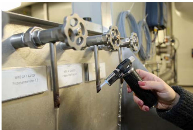
Abflammen einer Probenahmestelle
