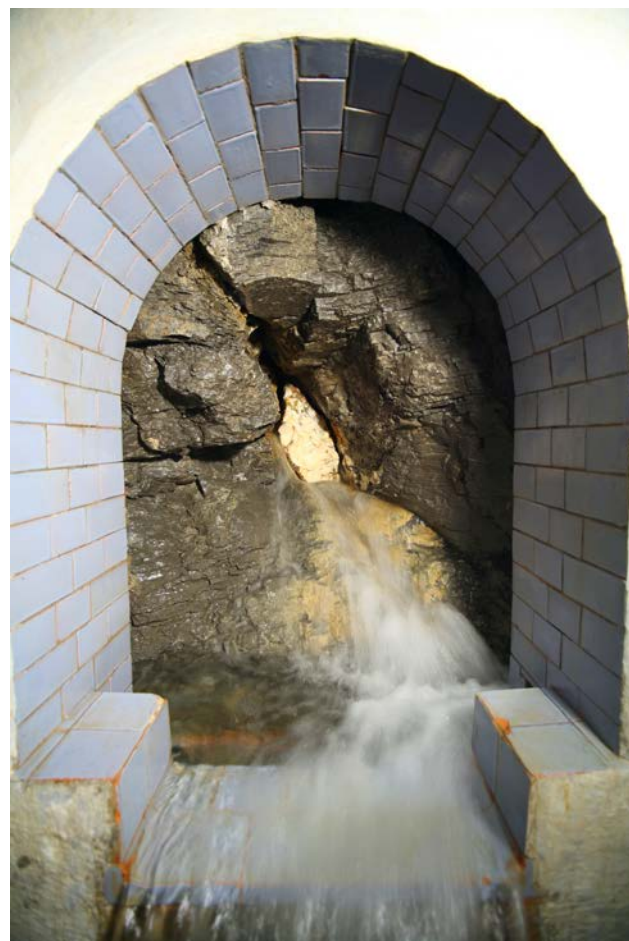
Spaltquelle im Norbertusheimstollen
