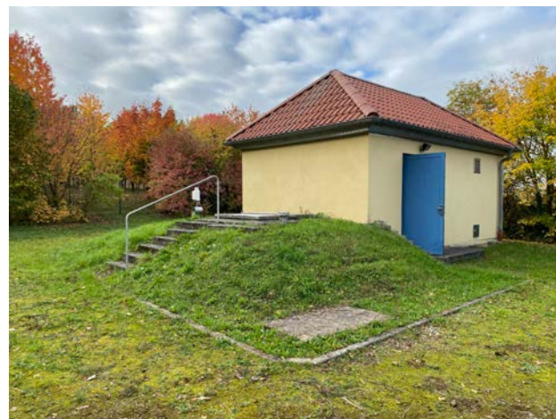
Außenansicht des Brunnens 1
