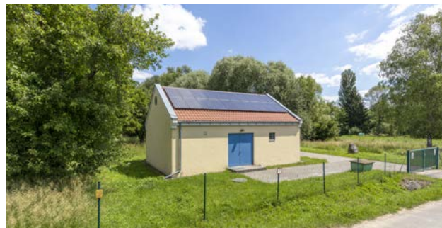
Außenansicht des Pumpwerkes Lengfeld
