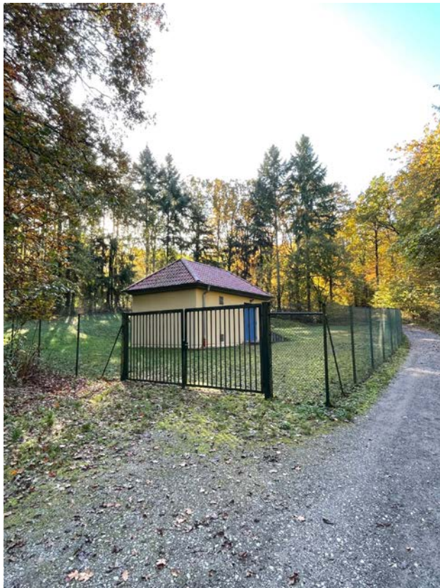
Außenansicht des Brunnens 2
