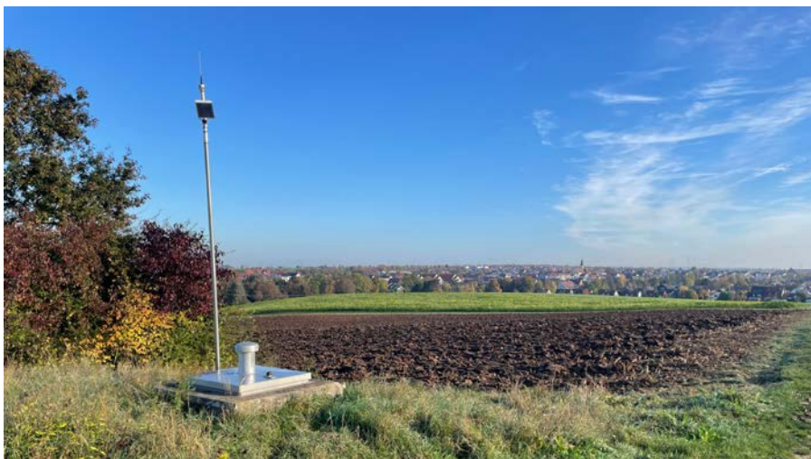
Schacht im Wasserschutzgebiet
