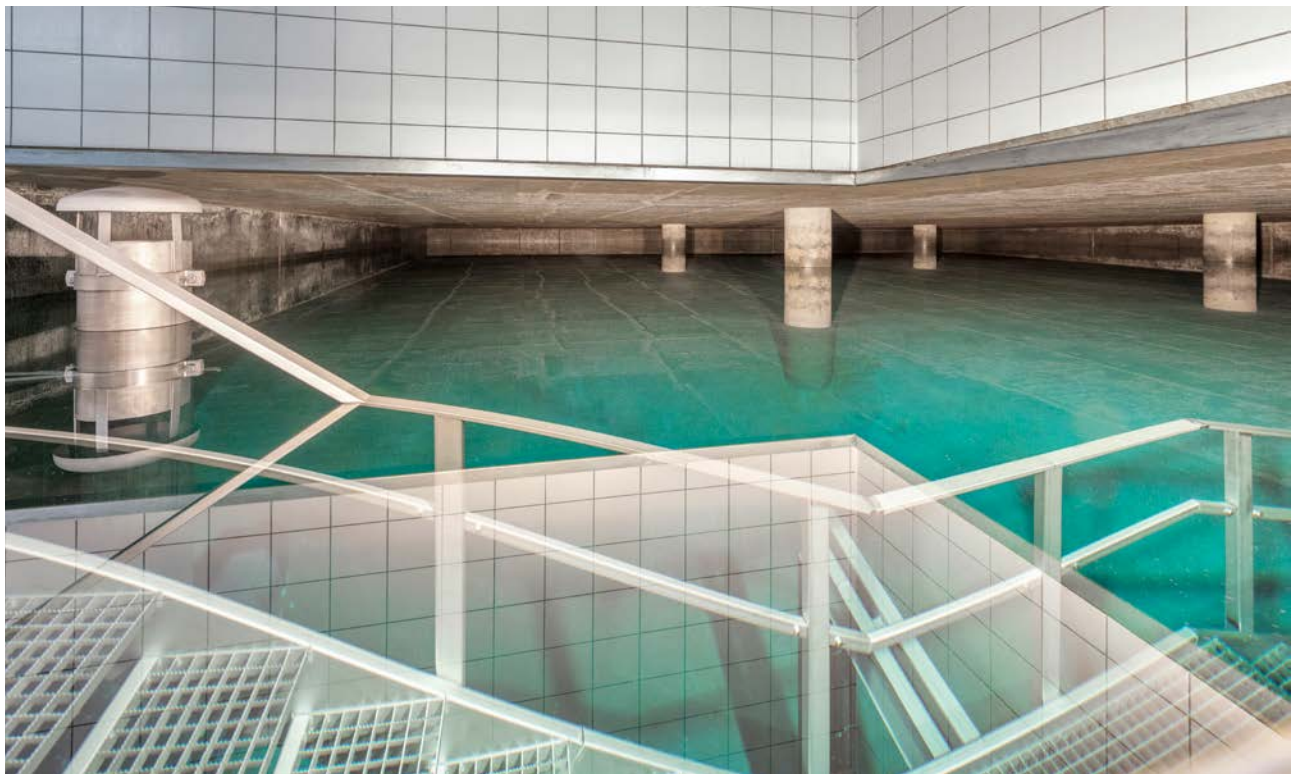
Wasserkammer im Hochbehälter Heiligenholz
