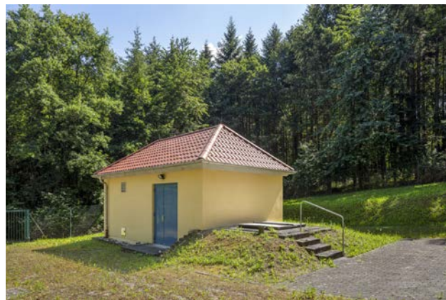
Außenansicht des Brunnens 2
