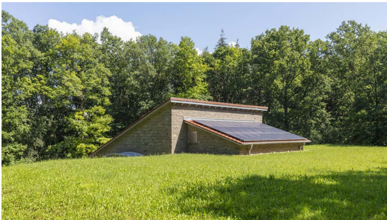
Außenansicht des Hochbehälters Heiligenholz mit PV-Anlage
