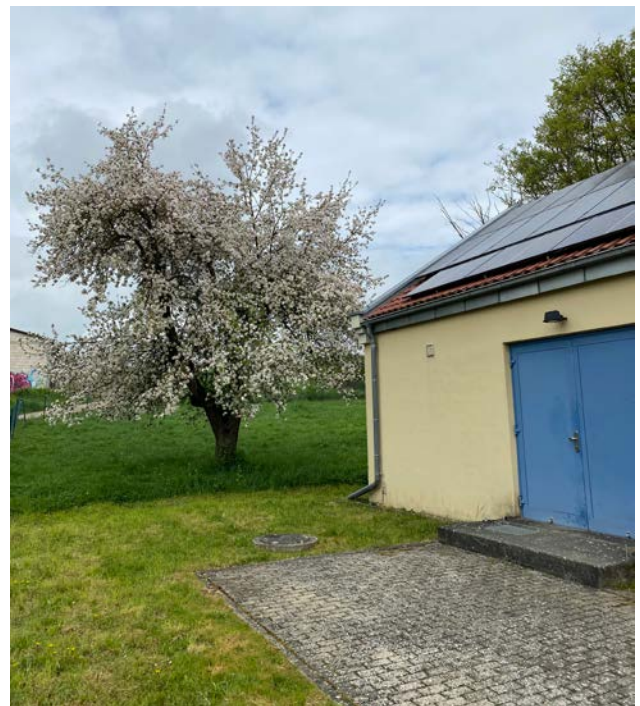
Außenansicht des Pumpwerkes Lengfeld
