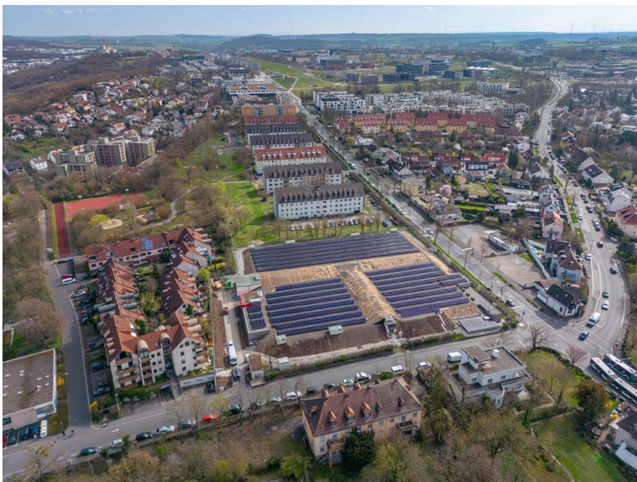
PV-Anlage auf dem Hochbehälter Galgenberg, Foto: Rolf Nachbar
