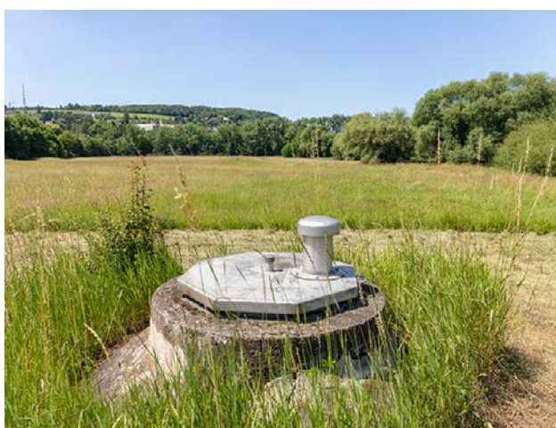
Fassungsgelände des Wasserwerkes Mergentheimer Straße
