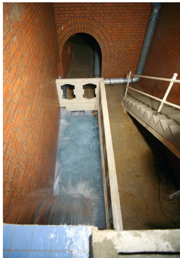
Wasserschloss im Norbertusheimstollen
