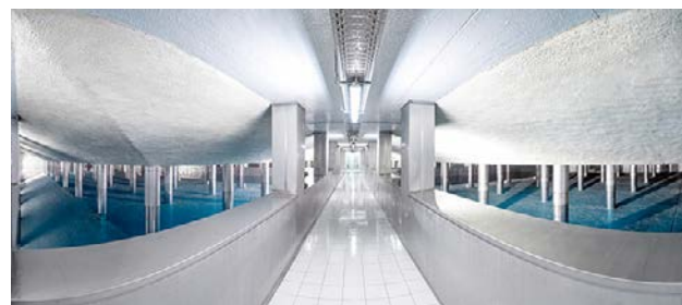
Wasserkammern im Hochbehälter Galgenberg
