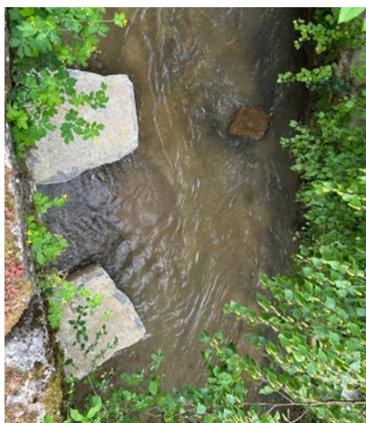
Flussbausteine Leinacher Bach in Zellingen
