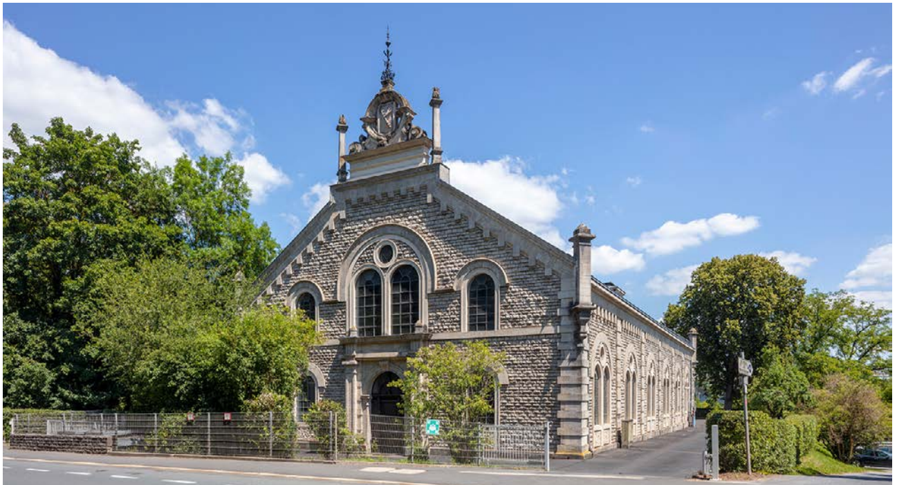
Wasserwerk Zell, Foto: Gerhard Hagen
