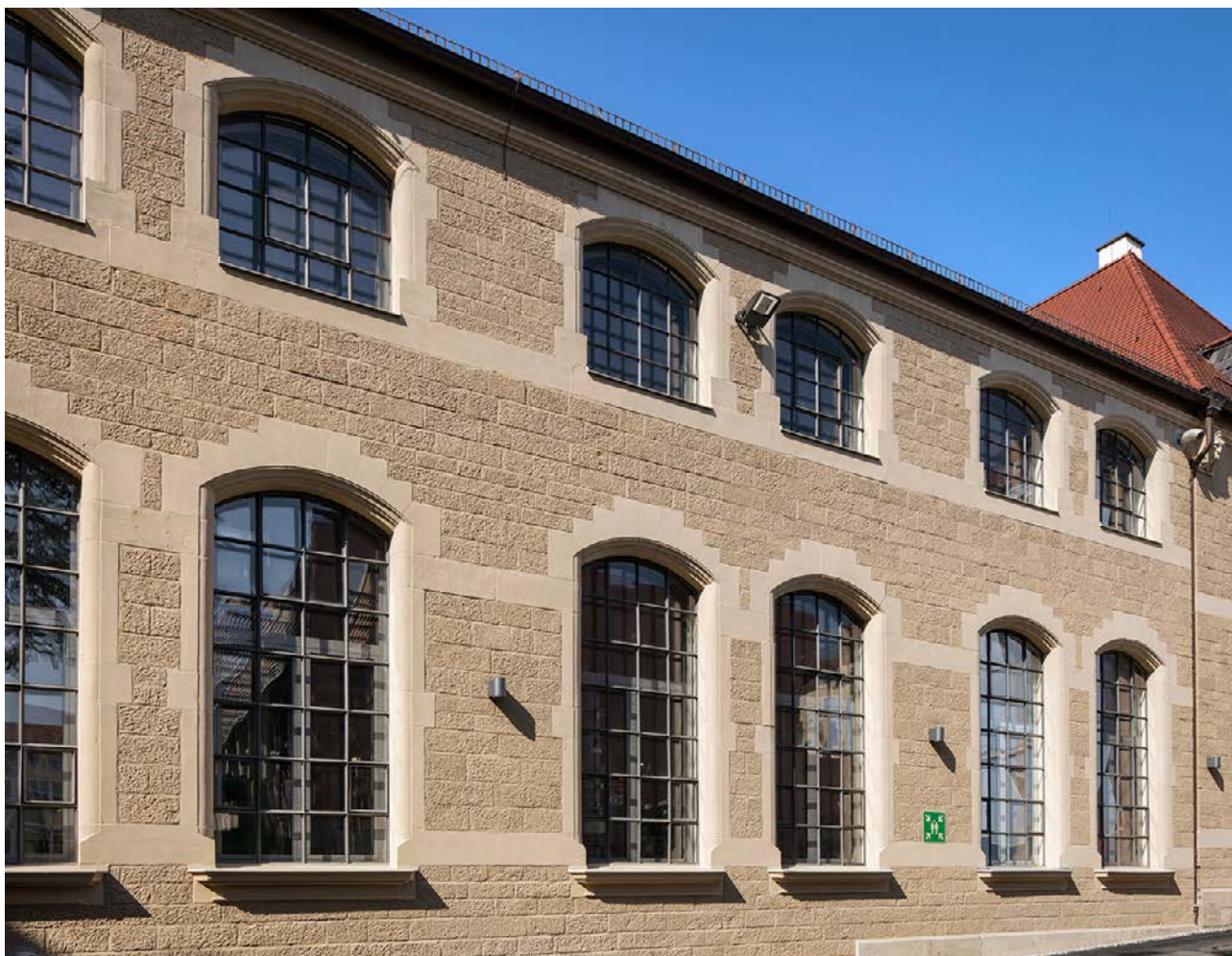
Wassserwerk Bahnhofstraße, Foto: Gerhard Hagen
