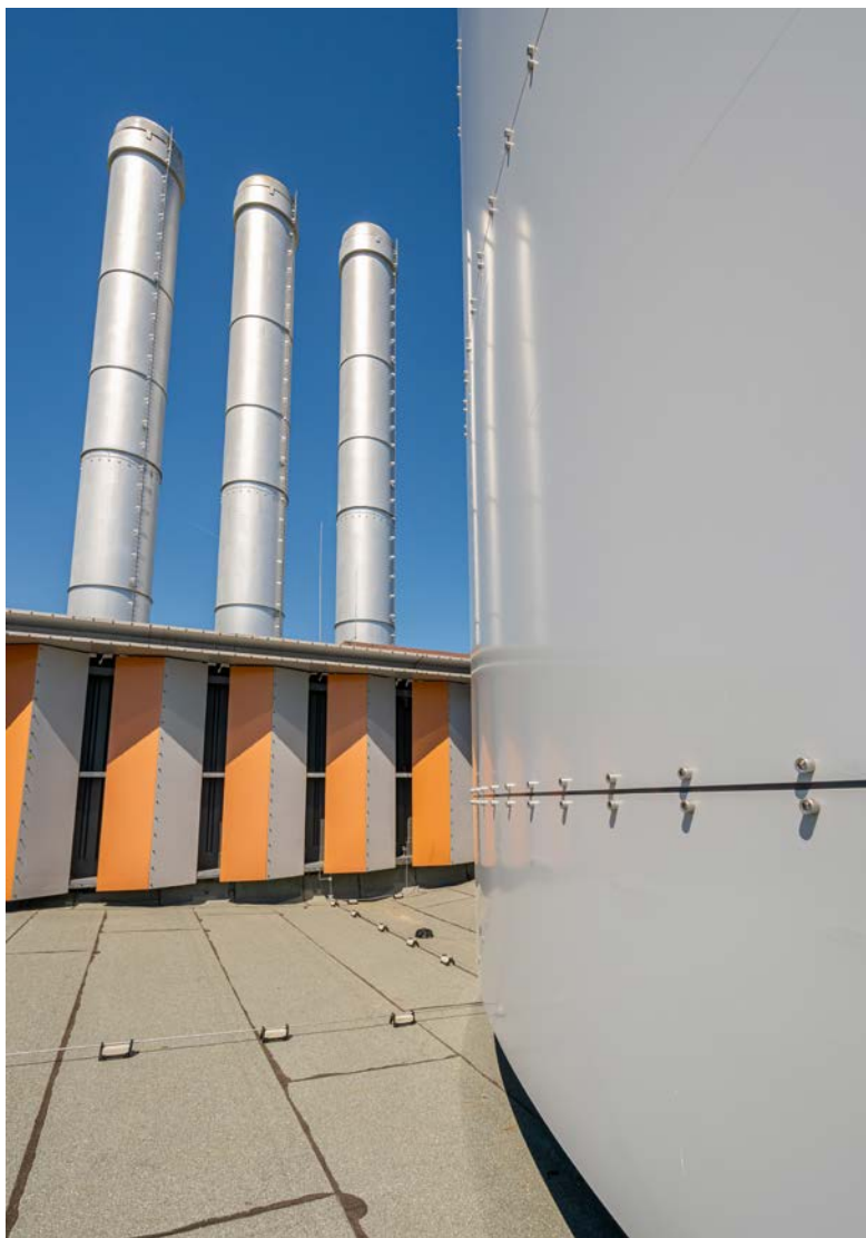
Aufnahme vom Dach des Heizkraftwerks mit Wärmespeicher im Vordergrund und den Kaminen im Hintergrund
