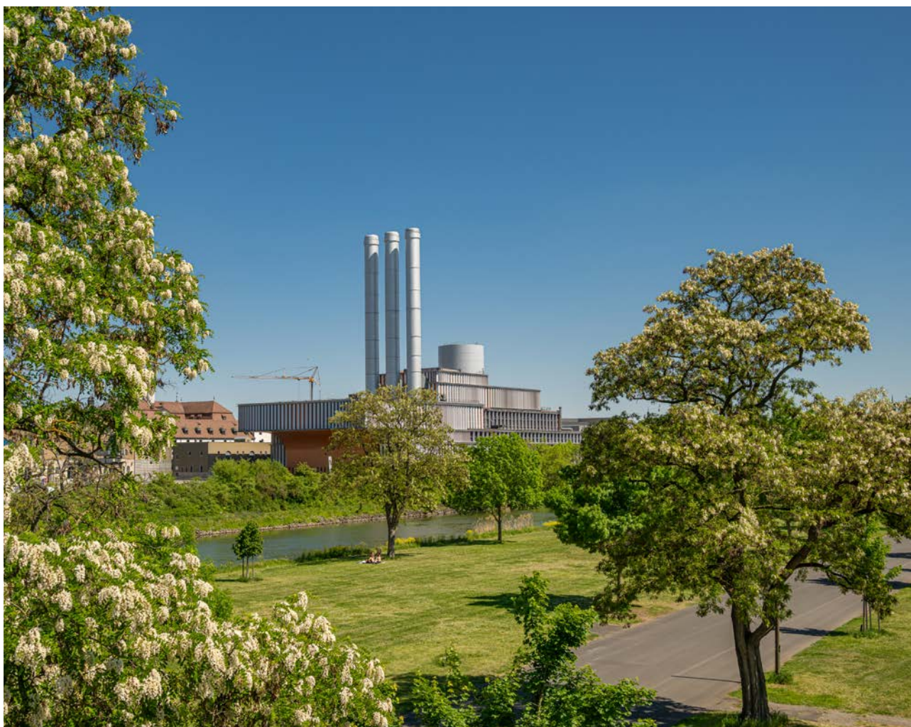
Aufnahme Heizkraftwerk von der Mainseite
