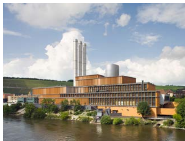
Nach der Modernisierung mit Speicher
