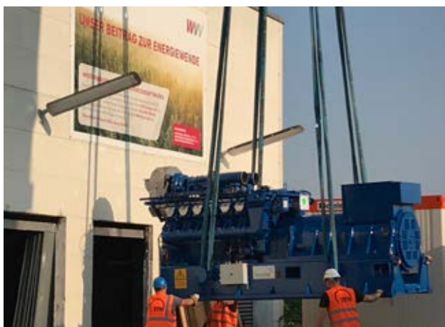
BHKW, Montage der neuen Gasmotoren 2018
