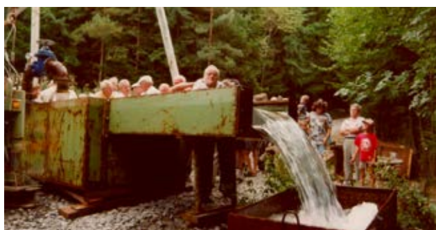
Pumpversuch am Brunnen 2
