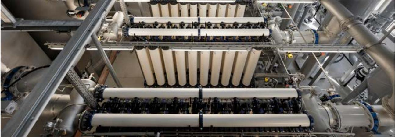
Anschließend wird das Wasser über eine Aktivkohlefilteranlage geleitet, in der organische Spurenstoffe entfernt werden können. Zum Einsatz kommen drei Filterstraßen mit je zwei hintereinandergeschalteten Filterkesseln. Durch die Reihenschaltung von zwei Filtern wird eine höhere Aufbereitungssicherheit gegenüber organischen Stoffen und eine weitergehende Ausnutzung der Adsorptionskapazität der Aktivkohle erreicht.
