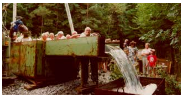
Pumpversuch am Brunnen 2
