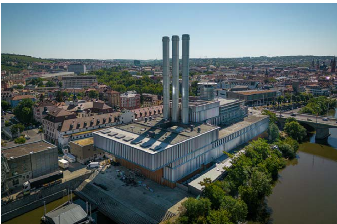
Heizkraftwerk mit Wärmespeicher
