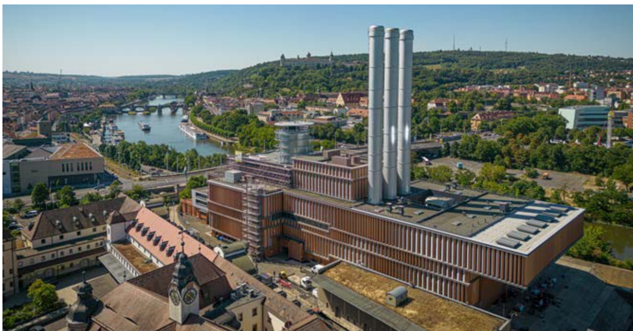
Heizkraftwerk mit Wärmespeicher
