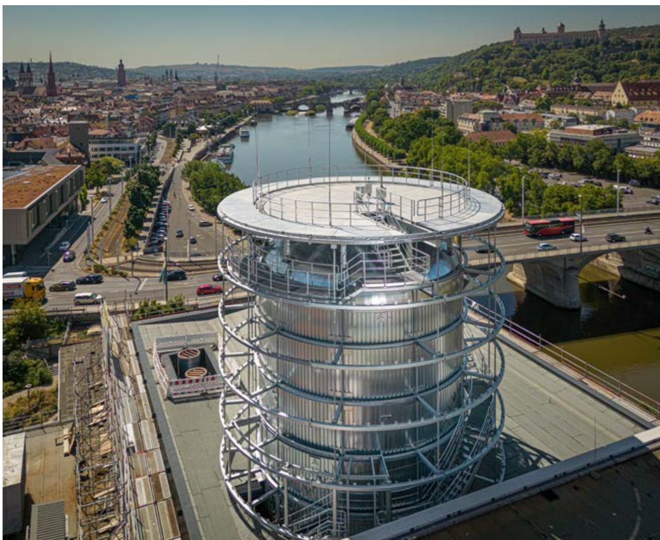
Das Heizkraftwerk mit dem neuen Wärmespeicher
