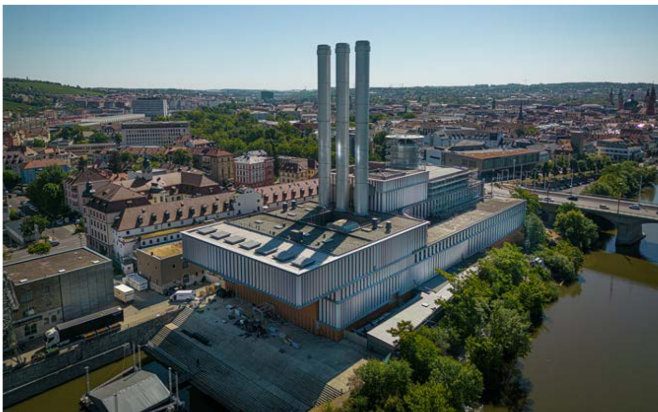
Heizkraftwerk mit Wärmespeicher
