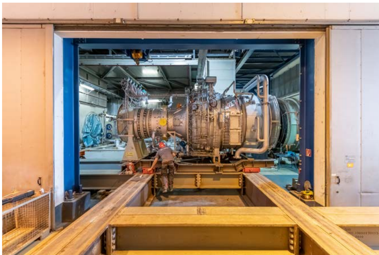
Montage der neuen Gasturbine GT I im Heizkraftwerk
