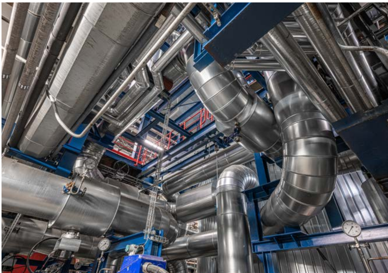
Neue Heißwasserleitungen im Heizkraftwerk
