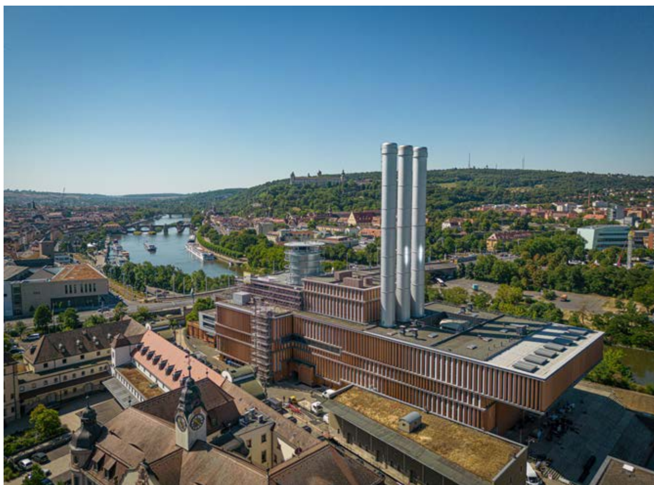
Heizkraftwerk mit Wärmespeicher
