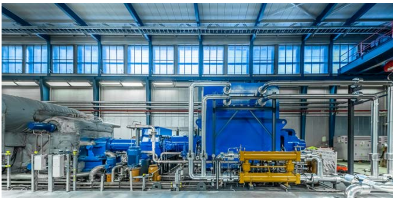
Neue Dampfturbine TS IV
