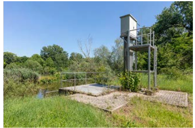
Mainwasserentnahmebauwerk des Wassserwerkes Mergentheimer Straße, Foto: Gerhard Hagen
