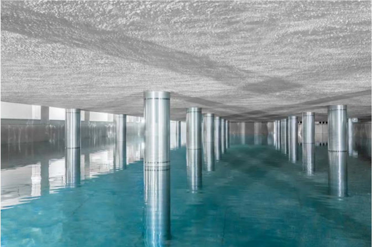
Kammer im Hochbehälter Galgenberg, Foto: Rolf Nachbar
