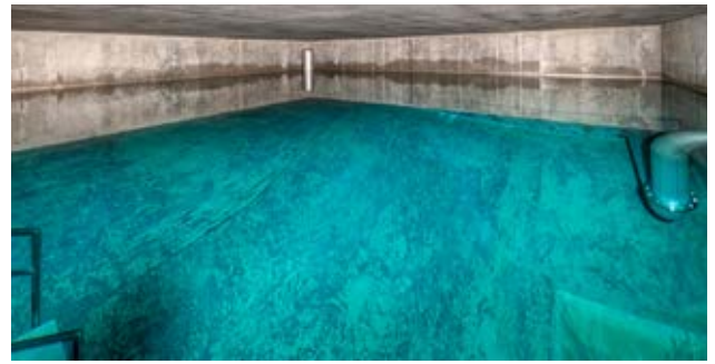
Reinwasserkammer im Wasserwerk Mergentheimer Straße, Foto: Gerhard Hagen
