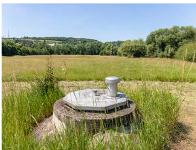
WW Mergentheimer Straße, Fassungsgelände
