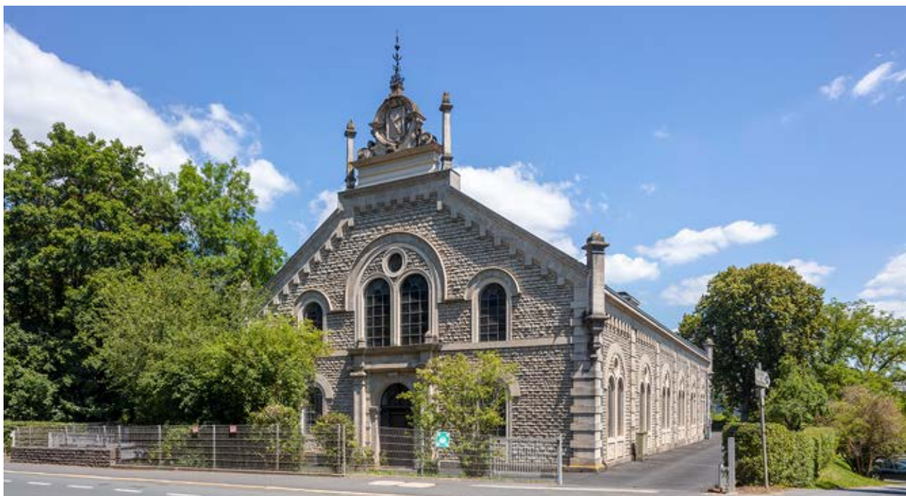
Wasserwerk Zell, Foto: Gerhard Hagen
