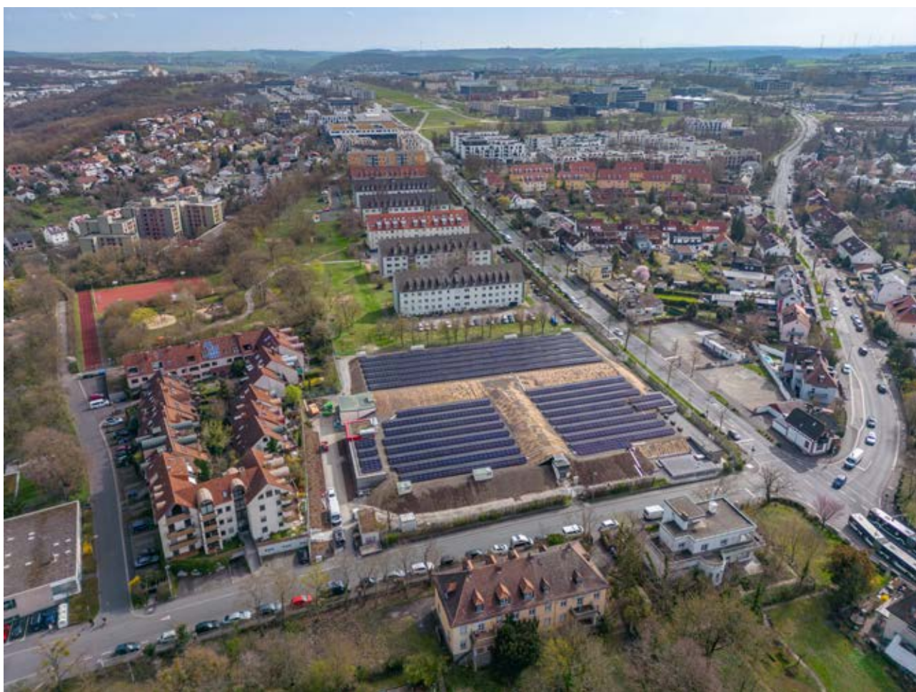
PV-Anlage HB Galgenberg, Foto: Rolf Nachbar
