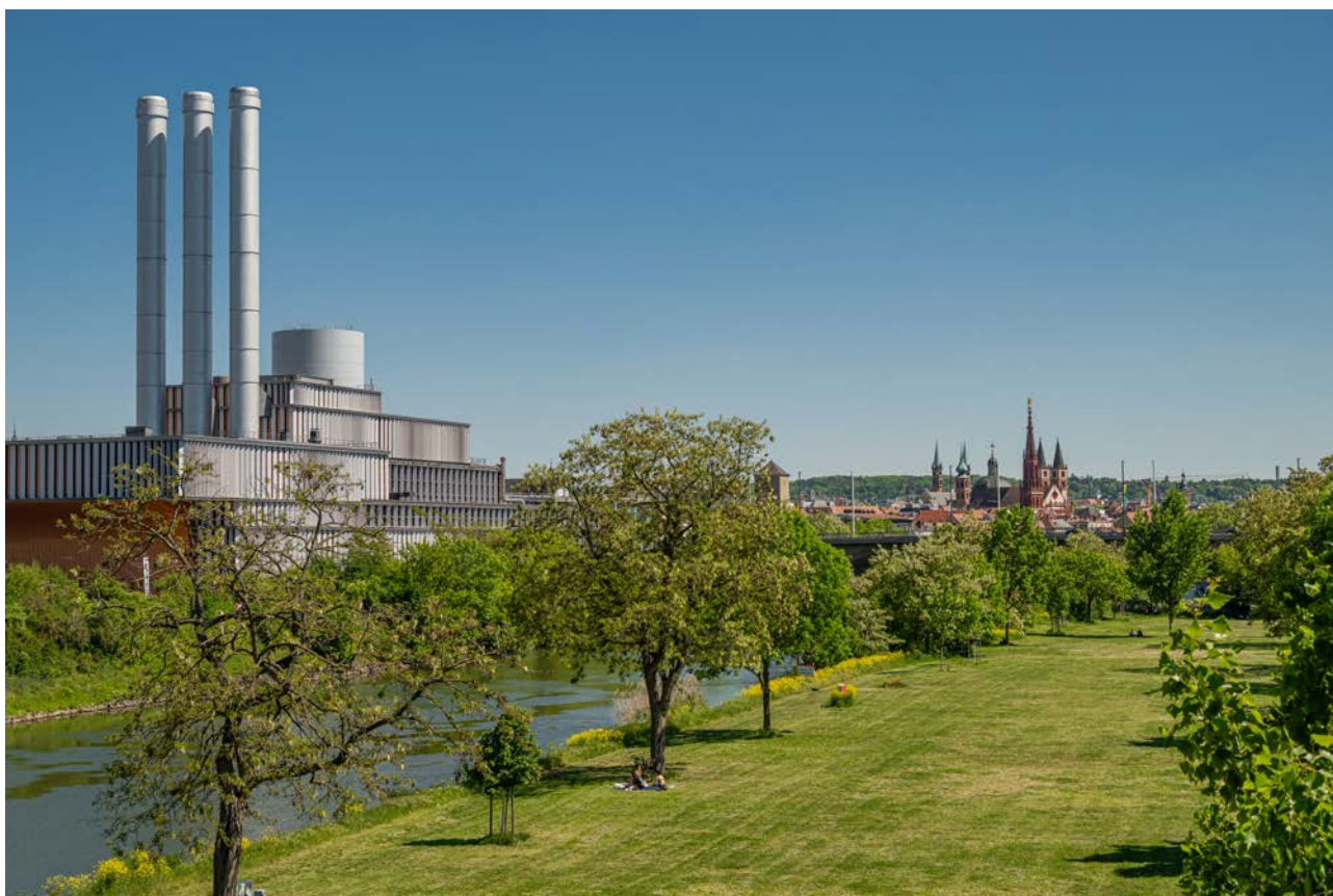
Heizkraftwerk mit Stadt Würzburg aus Richtung Brücke der Deutschen Einheit, Mainwiese
