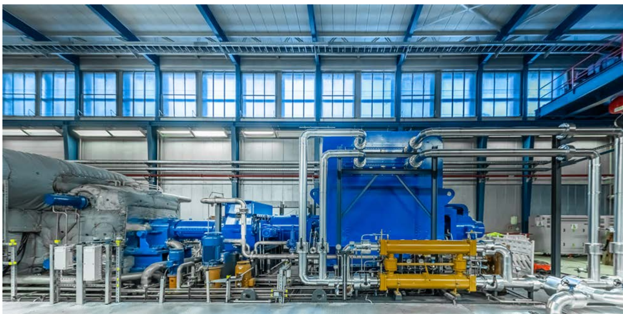
Neue Dampfturbine TS IV
