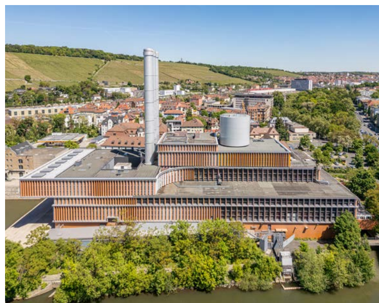
Luftaufnahme des Heizkraftwerkes von der Mainseite
