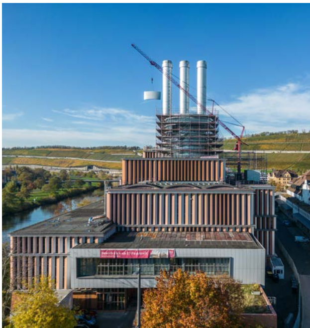
Montage Wärmespeicherfassade Herbst 2024
