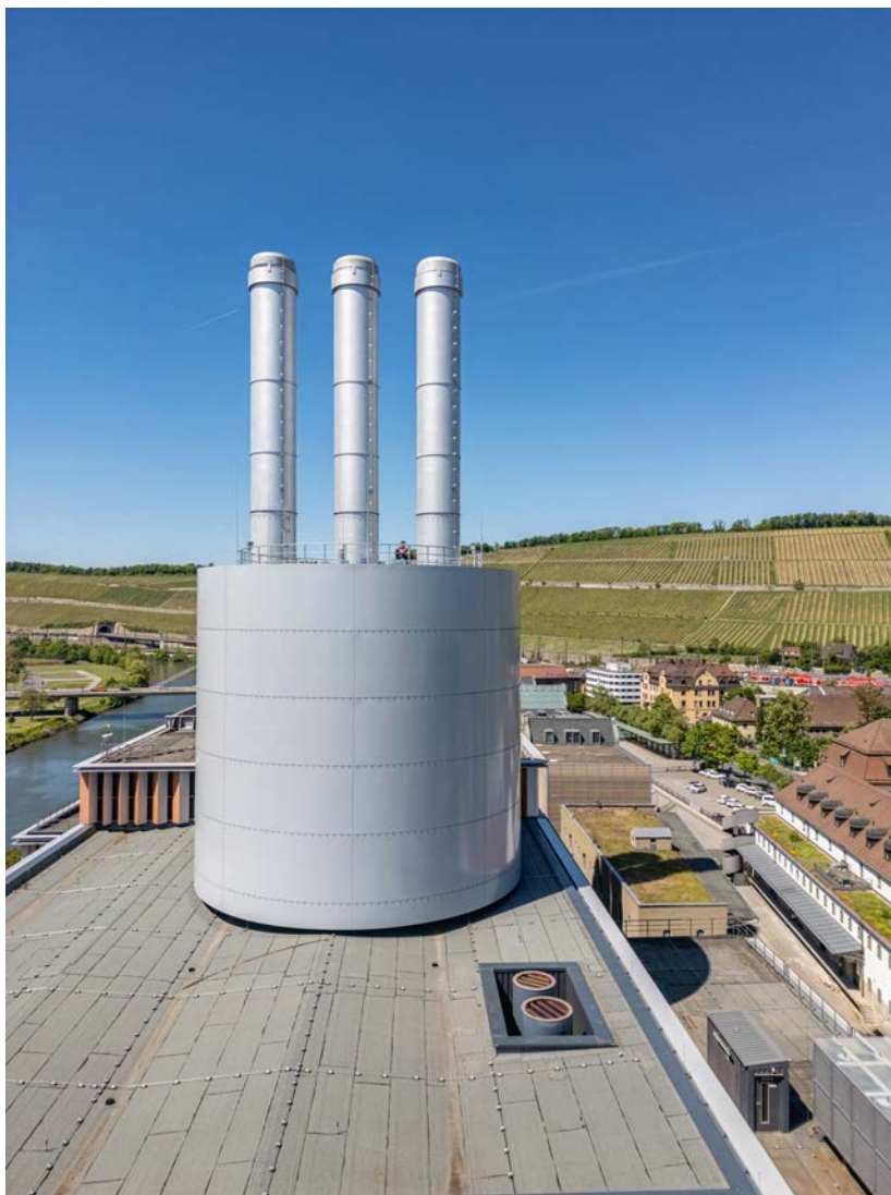
Luftaufnahme Wärmespeicher mit Kaminen aus Richtung Friedensbrücke
