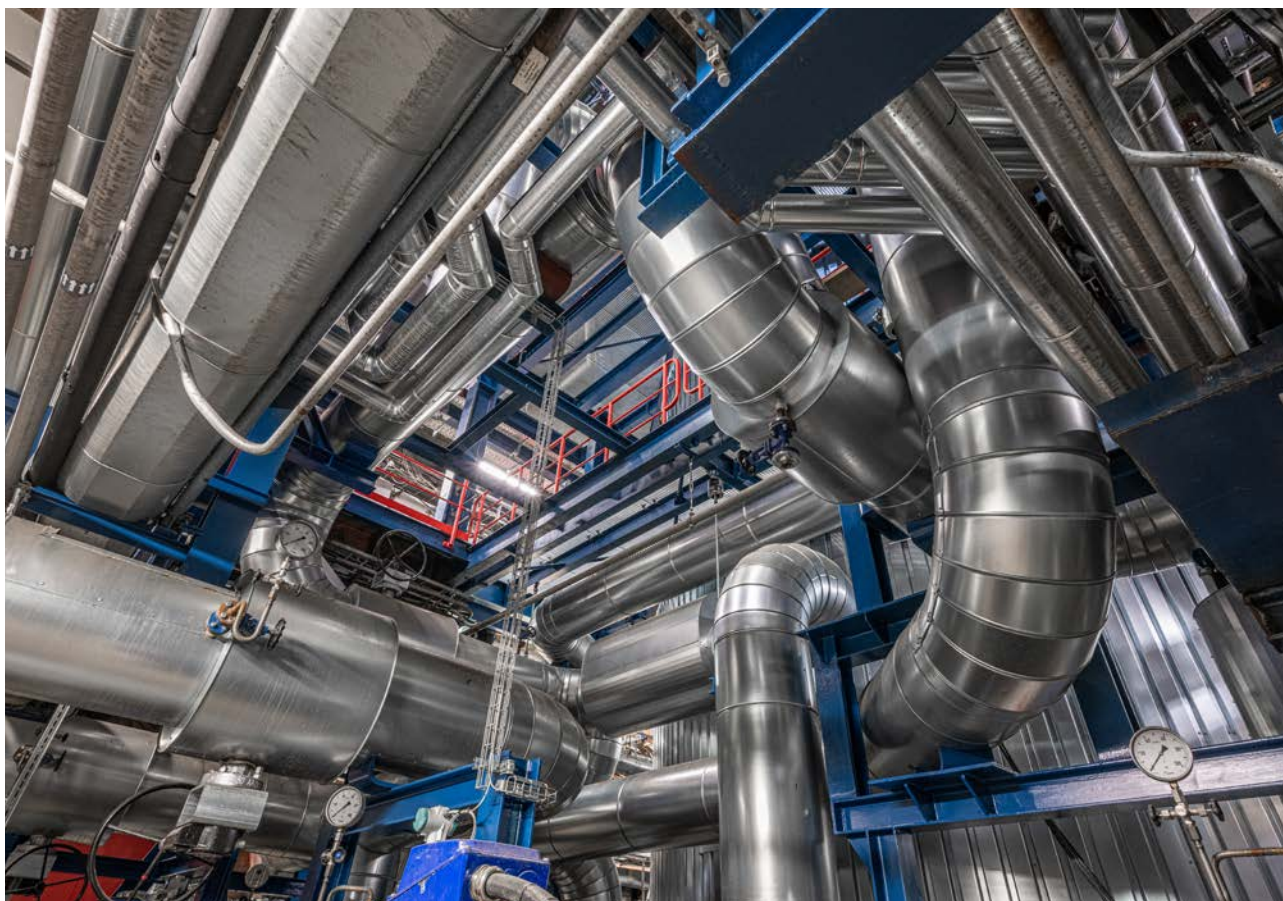
Neue Heißwasserleitungen im Heizkraftwerk
