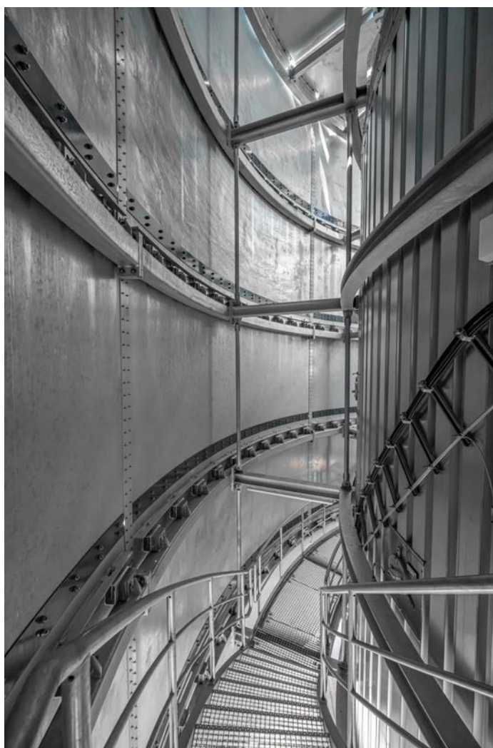
Treppenaufgang im verkleideten Wärmespeicher
