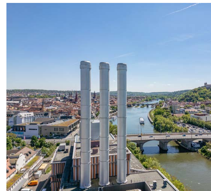
Eines der Herzstücke der Würzburger Wärmewende und der Fernwärmeerzeugung für die Region: Das Heizkraftwerk an der Friedensbrücke.
