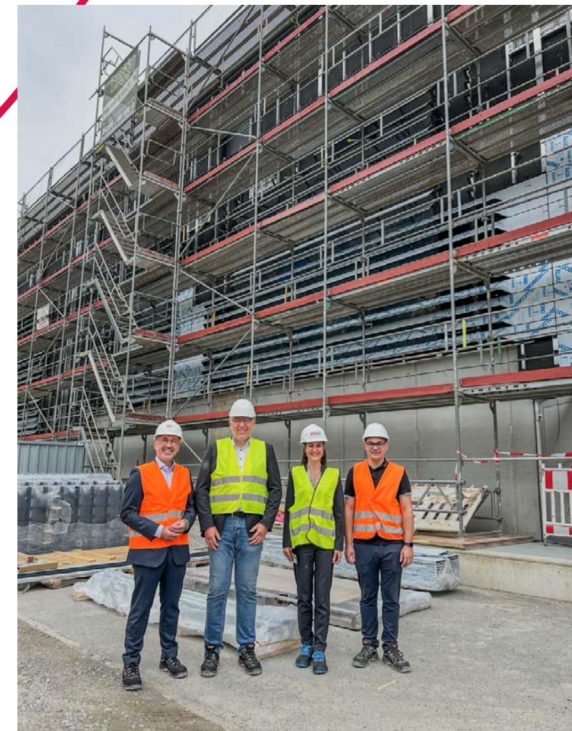
Die Außenfassade des Neubaus (hier der Stand im Sommer 2025) wird langsam sichtbar.
